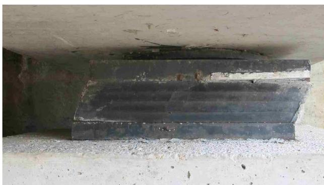
Figura 12. Dettaglio dello scorrimento tra la superficie di contatto dell'appoggio con l'intradosso della trave
