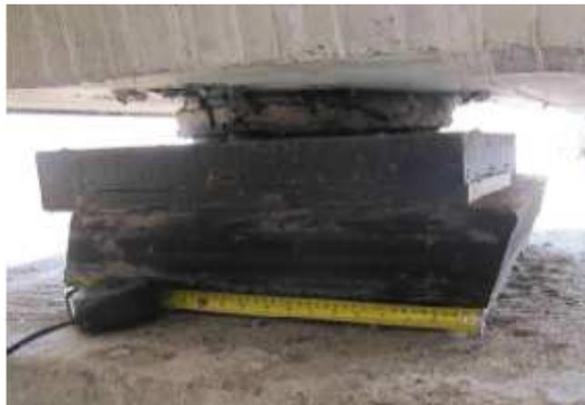
Figura 11. Dettaglio appoggio pila con scollamento della gomma dalla piastra superiore
