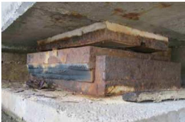
Figura 13. Dettaglio appoggio spalla con deformazione residua della gomma
