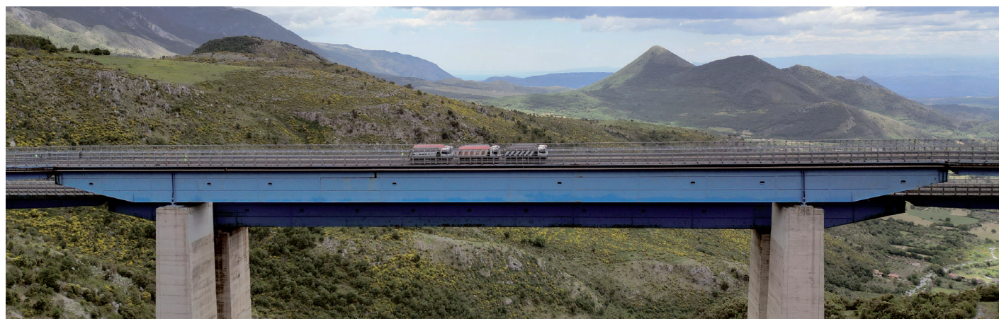
8. Le prove di carico: 250 t in mezzera della grande luce
