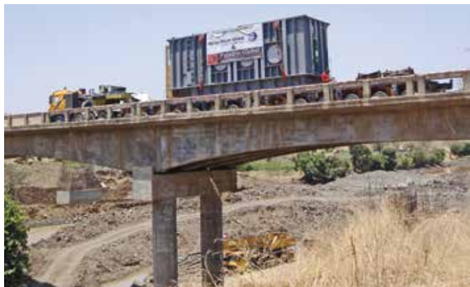
3A e 3B. Il collaudo e l'attraversamento dei trasformatori del Gibe sull'Omo
