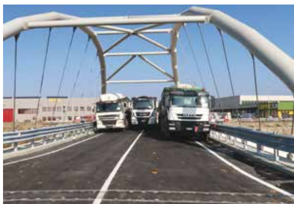
5A e 5B. Il collaudo del ponte ad arco di Bondeno
