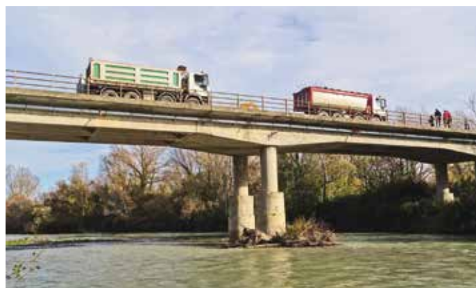
4. Le prove di carico sul ponte Nuovo sul Sangro
