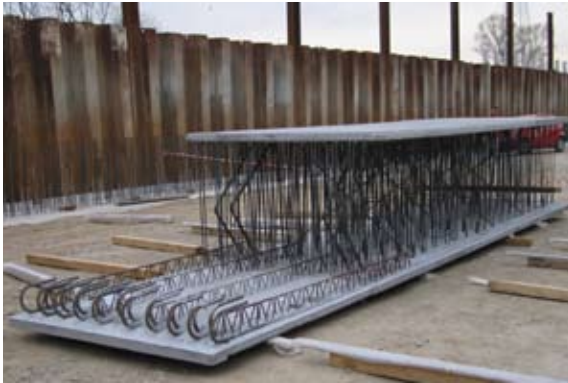
Foto 12 – Posa in opera di un pannello prefabbricato bilastra
