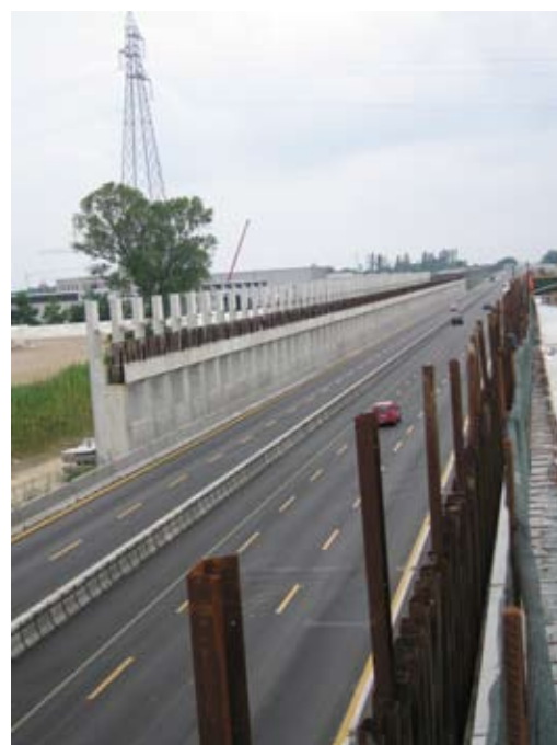
Foto 21 - Vista della carreggiata Sud durante la costruzione della g.a. (fase 2)
