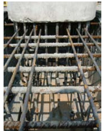
Foto 19 – Dettaglio di un nodo pilastro-fondazione prima del getto di collegamento
