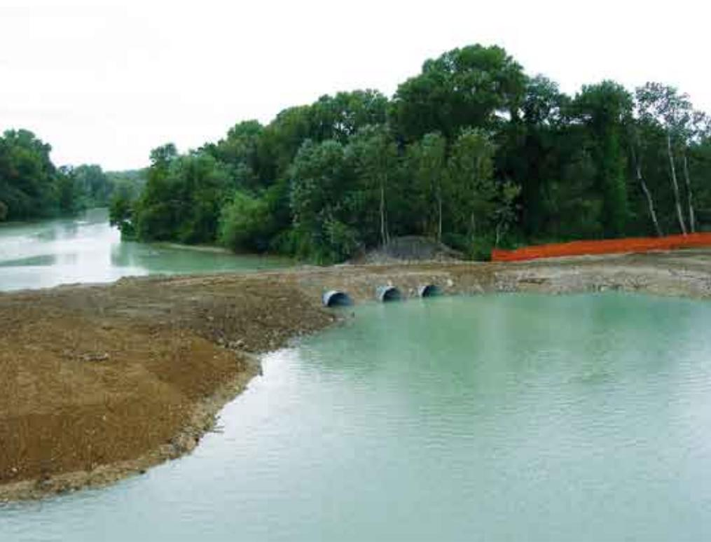
**Foto 5** – Le opere provvisorie eseguite per le lavorazioni in alveo
