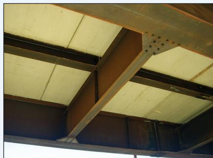
*Carpenteria delle campate a sezione di altezza costante trave metalliche*
