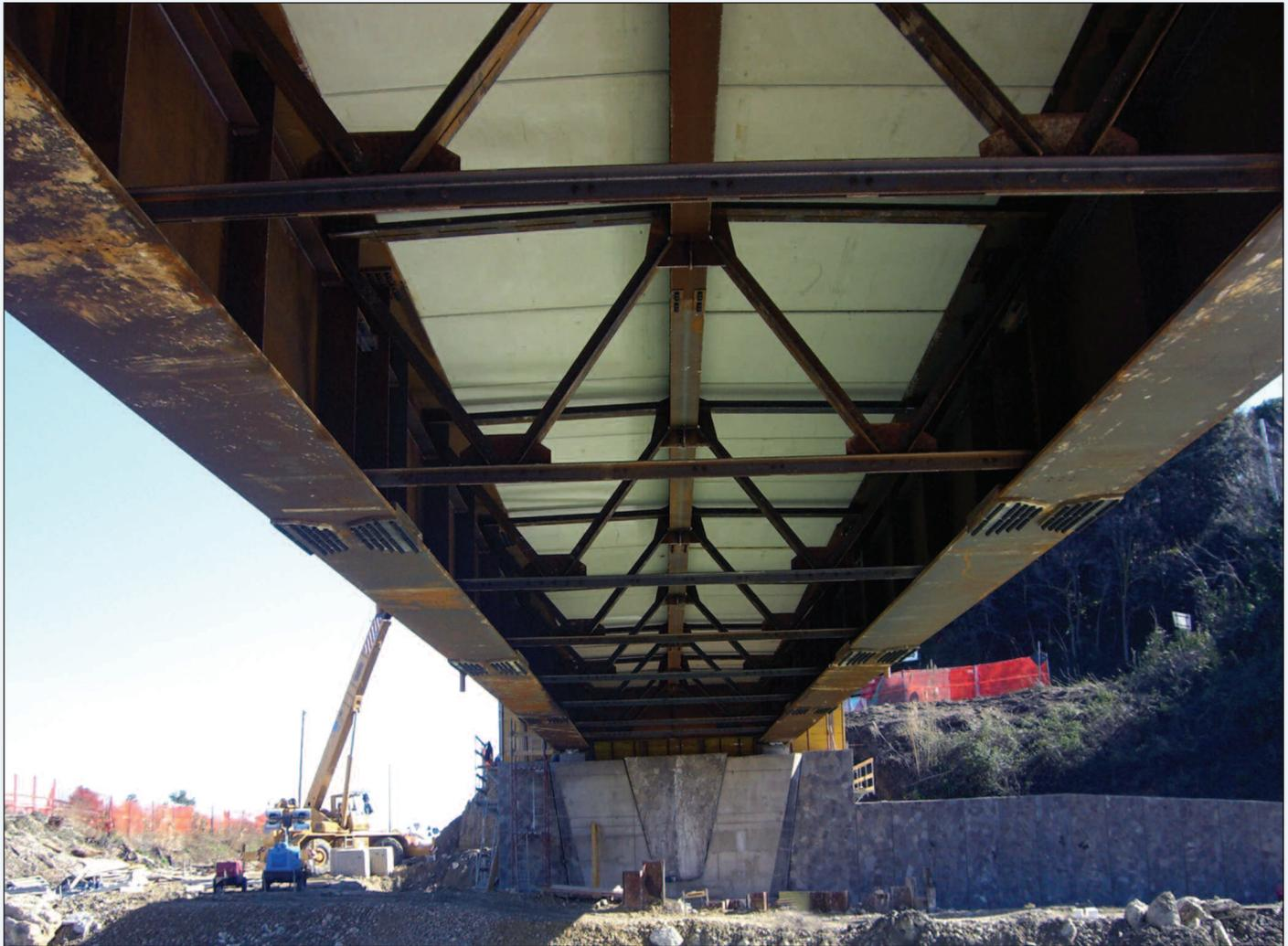
*Carpenteria delle campate con travi ad altezza variabile*
