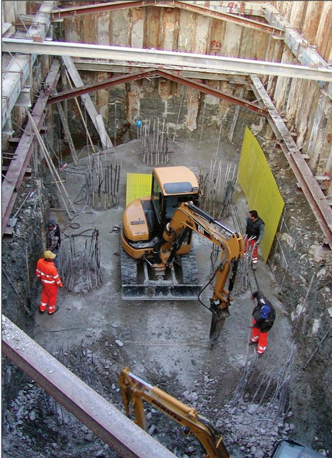
La fondazione in alveo con il tappo di fondo in jet-grouting
