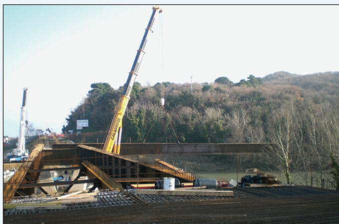
L'armatura della soletta ed il sollevamento delle travi della campata sul fiume
