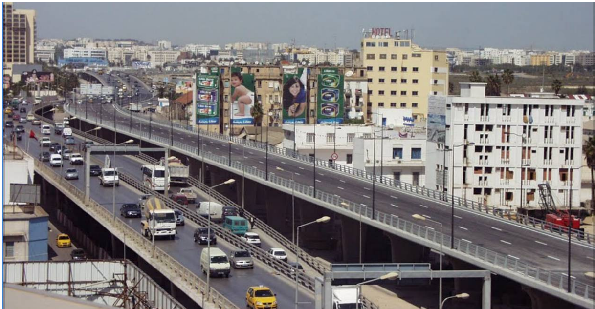
Figura 1 – Veduta del fly-over appena terminata la costruzione dell'OA2
