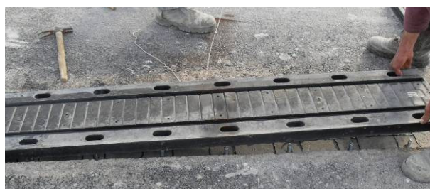
Figura 20 – Posa in opera del giunto longitudinale gli impalcati esistenti.
