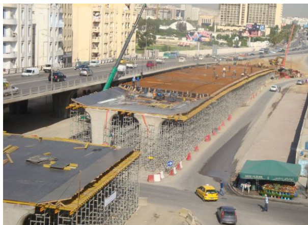
Figura 4 – Il viadotto OA2 in fase di costruzione
