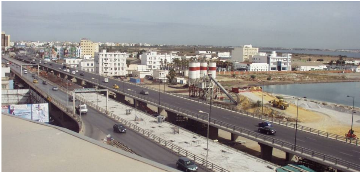
Figura 21 – Veduta del fly over. Il viadotto OA2 completato e aperto al traffico (verso il mare) e il tratto OA1 in fase di costruzione
