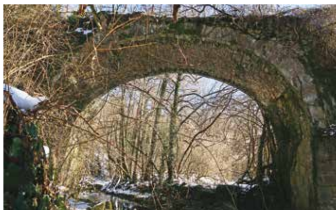
3. Il ponte ad arco in muratura sotto l'ospedale di Amatrice
