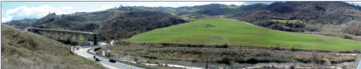
4. Una panoramica della colata di frana con il vecchio viadotto Ingotte demolito
