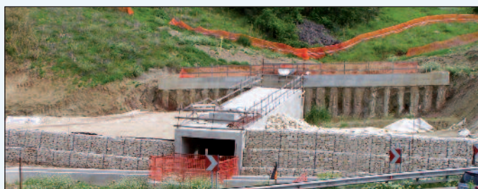
7. L'attraversamento di compluvi: paratie di monte, tombino idraulico e gabbionate di sottoscampa
