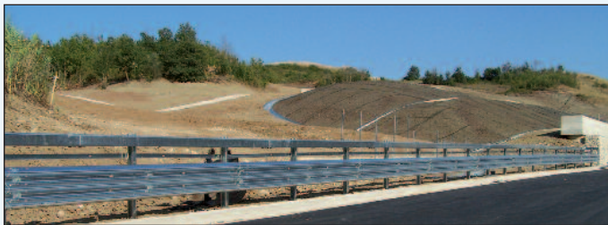
8. Trincee drenanti sul pendio e sistema di canalizzazioni per la regimentazione delle acque
