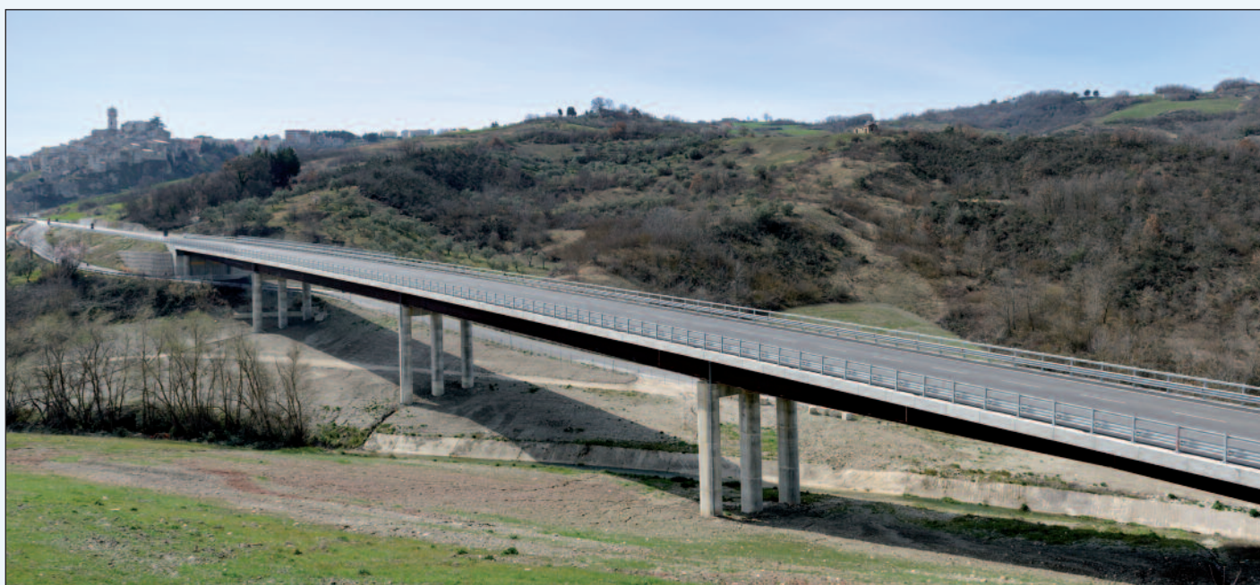
1. Il nuovo viadotto Ingotte I lungo la Fondovalle del Biferno
