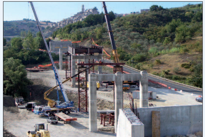
10. Il viadotto Ingotte I in costruzione
