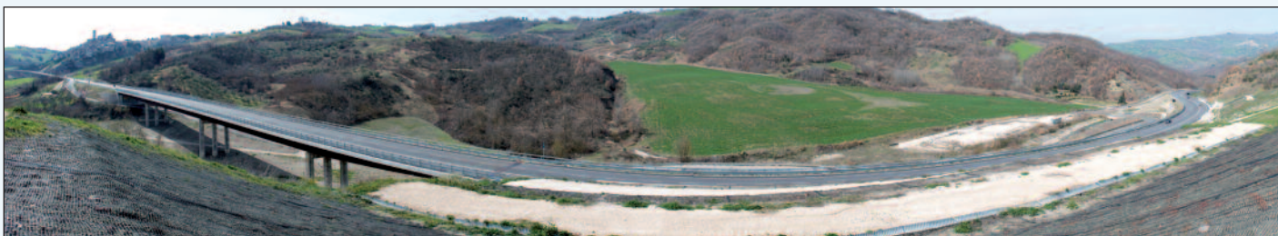
5. Una panoramica del nuovo tracciato stradale dopo l'esecuzione dei lavori
