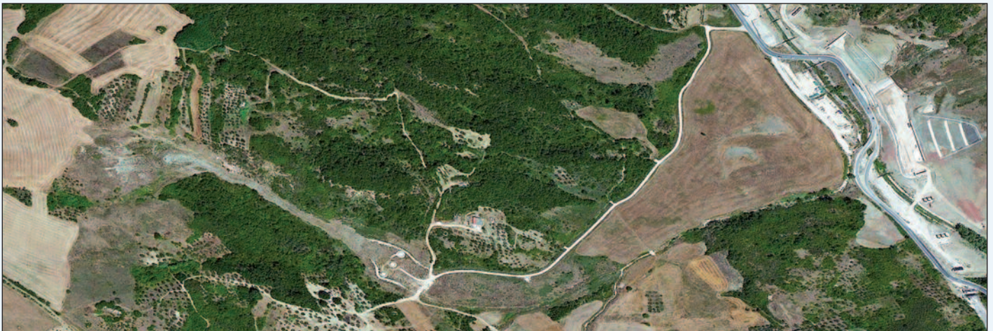
2. Una veduta aerea della lunga colata di frana con la deviazione provvisoria della strada
