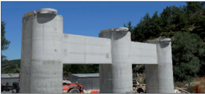
13. Un dettaglio della pila del viadotto Ingotte II con i riteggi sismici integrati con gli appoggi
