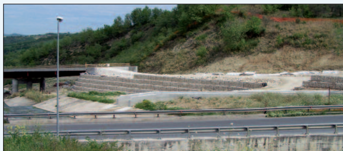
6. Le gabbionate di sottoscampa del corpo stradale
