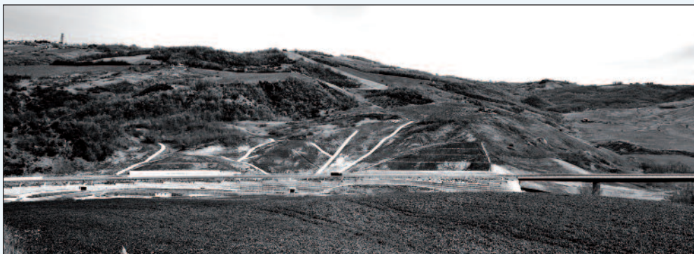
9. Il versante destro del vallone al termine degli interventi di protezione
