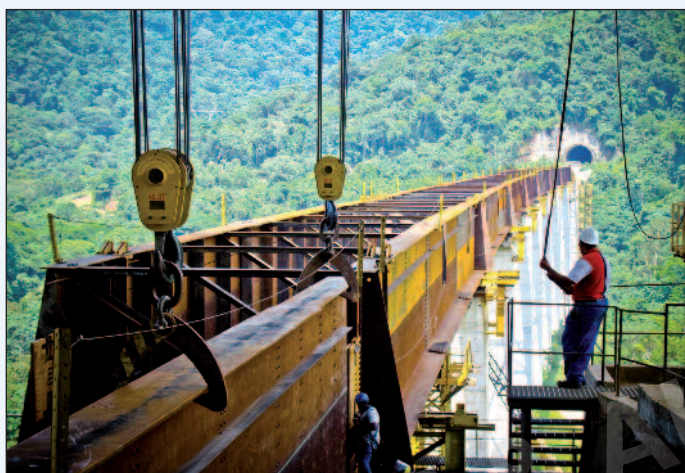
Figura 5 - Il varo del viadotto ferroviario C2-1
