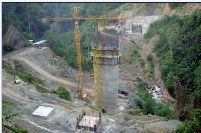
Figura 2 - Il viadotto della Colorado in costruzione
