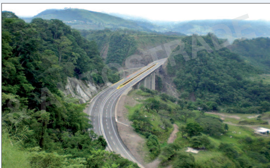
Figura 1 - Il viadotto della San Juana lungo la Panamericana
