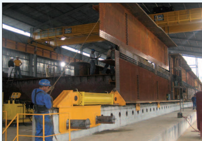
Figura 7 - L'assemblaggio per la bullonatura e il varo a spinta del viadotto ferroviario V1-1
