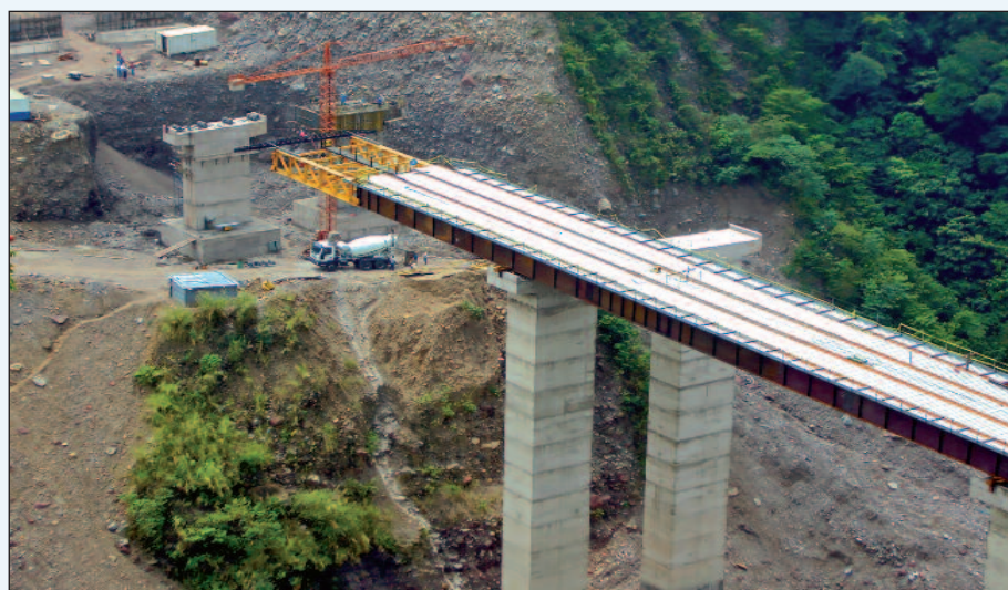
Figura 9 - Il varo della San Juana con lamiera grecata già posizionata per il getto della soletta
