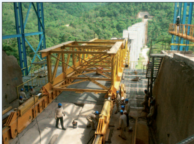
Figura 6 - L'area ricavata sulla spalla per il varo del viadotto C2-1
