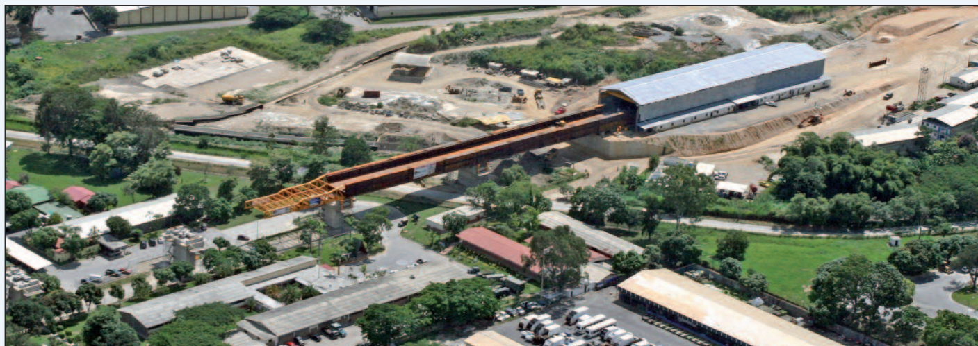
Figura 4 - Il viadotto ferroviario V1-1 ad inizio spinta
