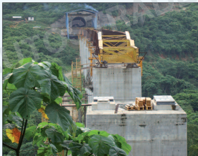
Figura 10 - Il varo in curva del viadotto C2-1
