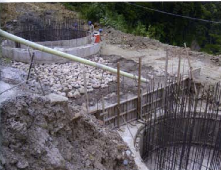
Fig. 19 - L'armatura dei pozzi di fondazione della spalla nord
