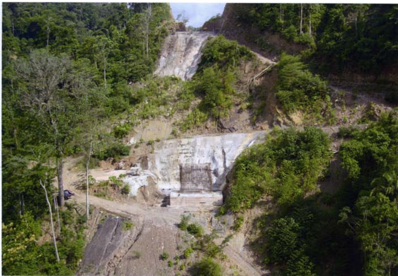
Fig. 24 - Gli interventi di consolidamento sul versante sinistro; in alto le opere realizzate al di sotto della spalla sud e in basso il consolidamento degli scavi della pila 1
