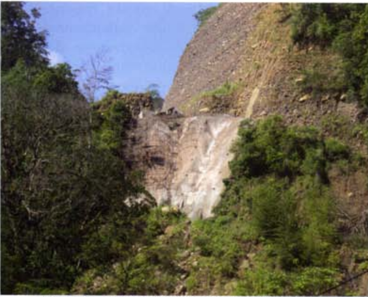
Fig. 21 - L'intero intervento di chiodatura e spritz beton del versante a valle della spalla sud
