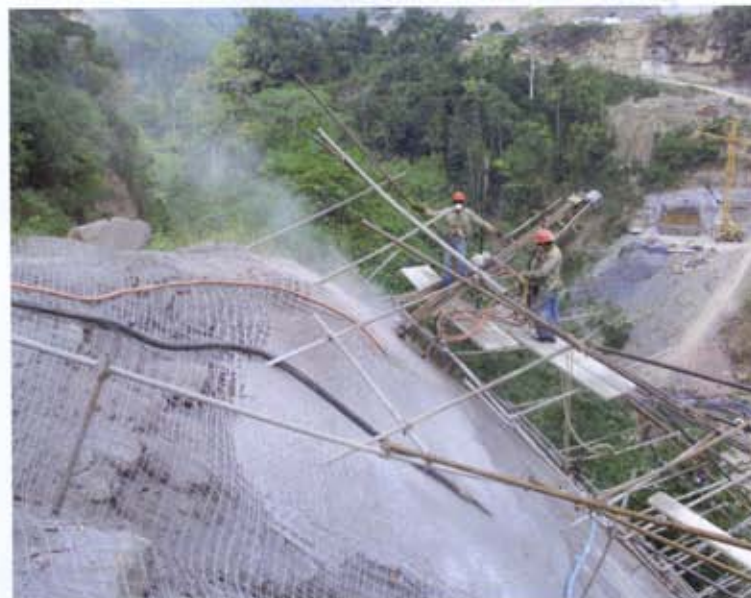
Fig. 20 - La chiodatura del versante a valle della spalla sud
