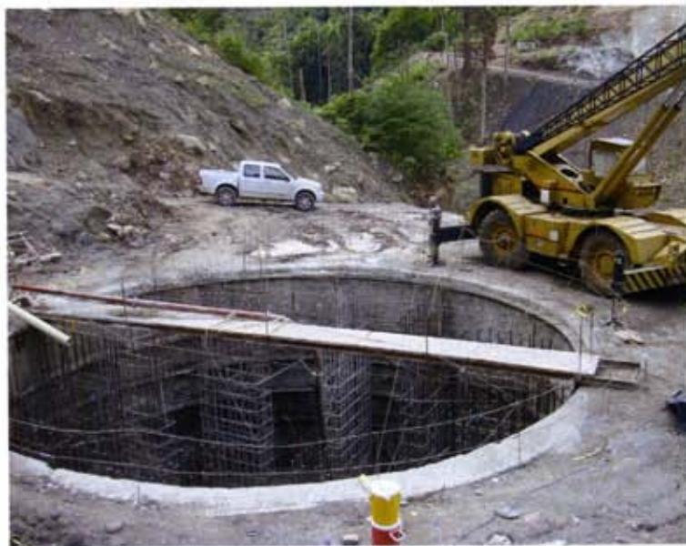
Fig. 13 - Armatura radiale del pozzo della Pila 2
