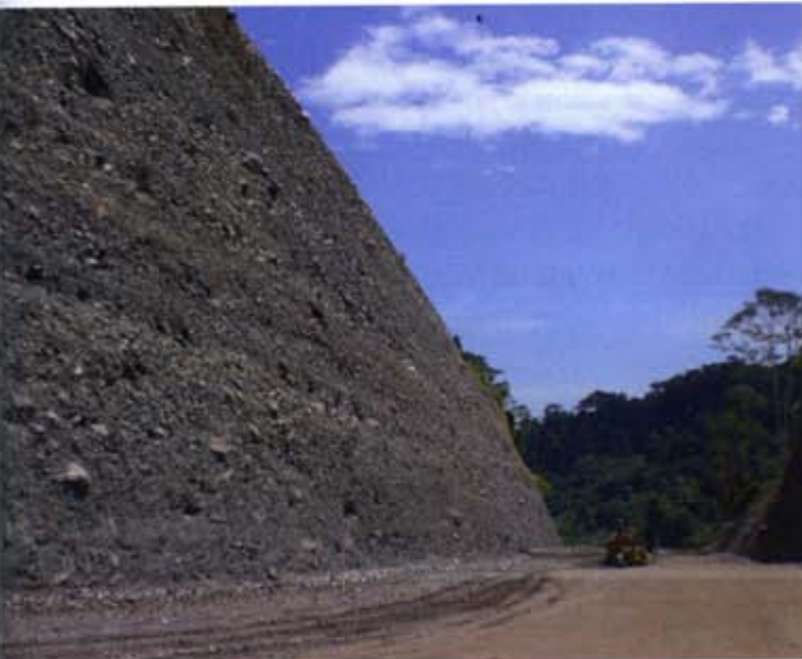
Fig. 4 - La profonda trincea scavata nei depositi della "Terrazza de Colon" prima della spalla destra del viadotto
