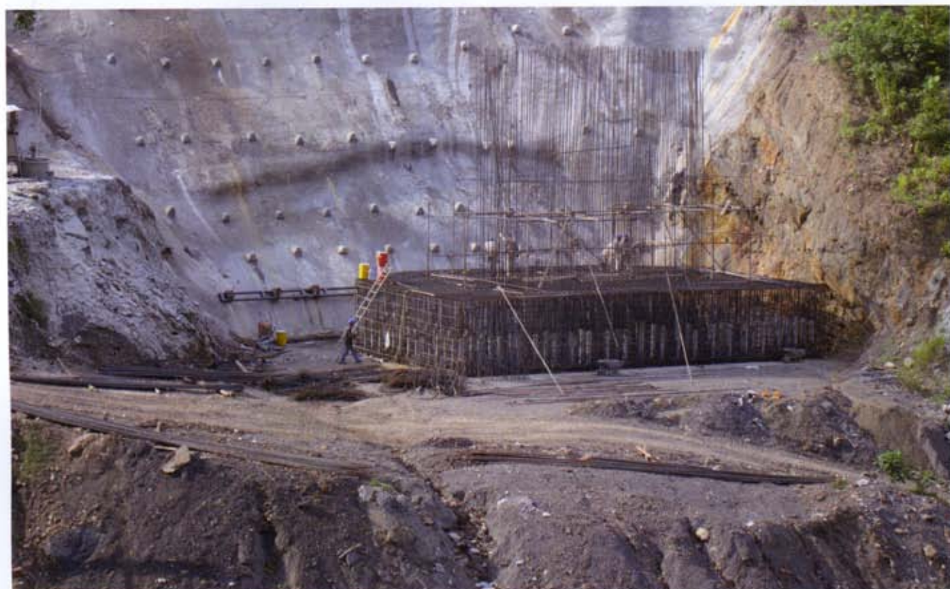
Fig. 23 - L'intervento di tirantatura completato sugli scavi della pila 1
