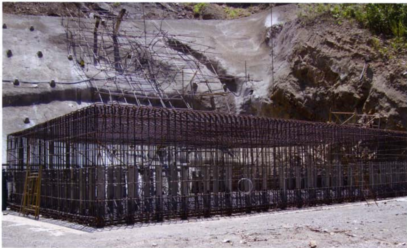
Fig. 11 - Esecuzione dei micropali e armatura del plinto della pila 1
