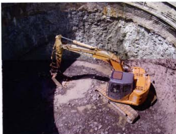
Fig. 12 - Scavo del pozzo della Pila 2
