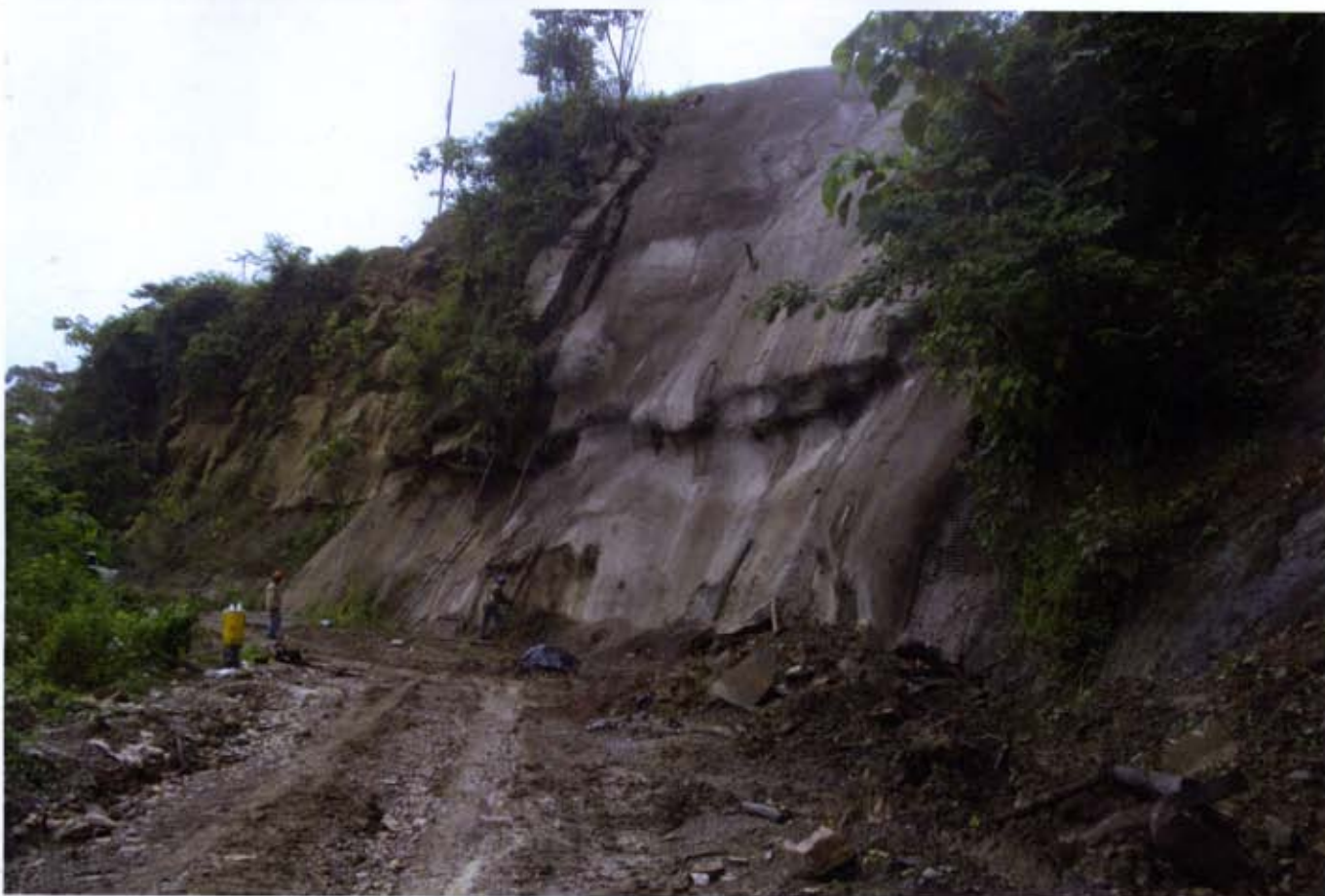
Fig. 29 - I banconi di arenaria dopo l'intervento di chiodatura
