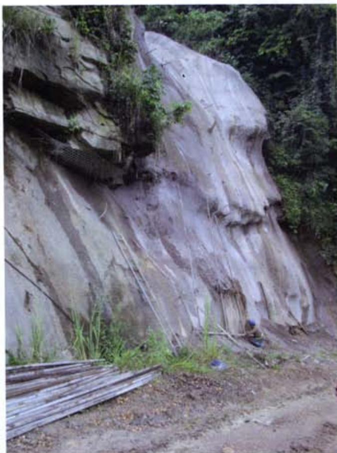
Fig. 30 - I banconi di arenaria affetti da fenomeni di "toppling", dopo l'intervento di chiodatura
