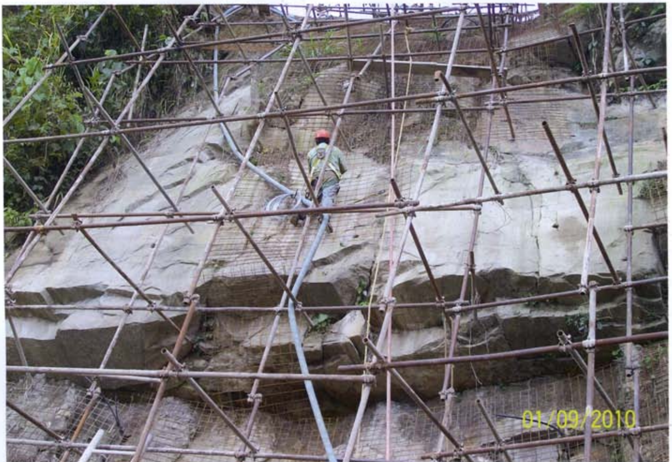
Fig. 27 - Gli interventi di chiodatura del bancone di arenaria della spalla nord
