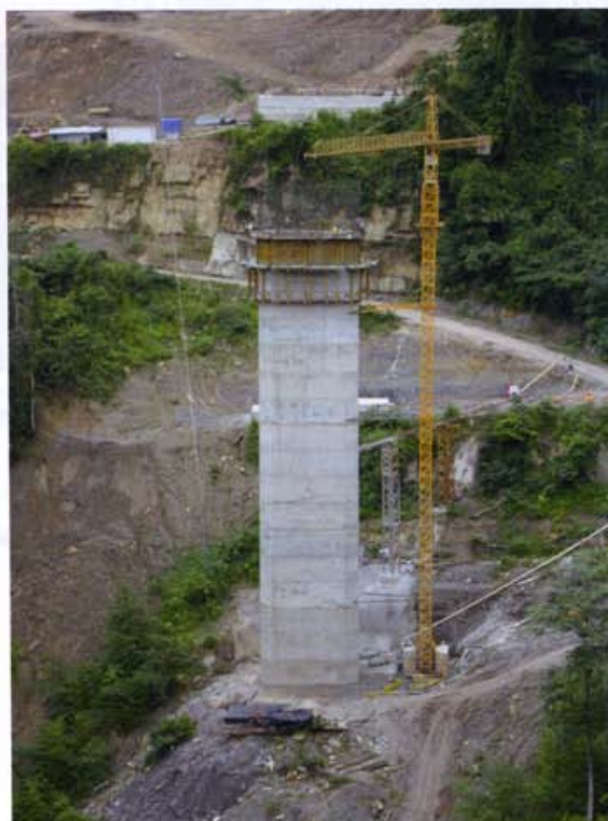
Fig. 31 - La sponda destra con in primo piano la pila 2 in elevazione e in alto la spalla nord con gli interventi di chiodatura in corso
