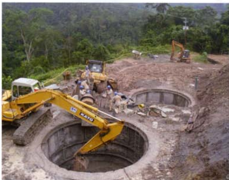
Fig. 18 - I pozzi di fondazione della spalla nord durante lo scavo
