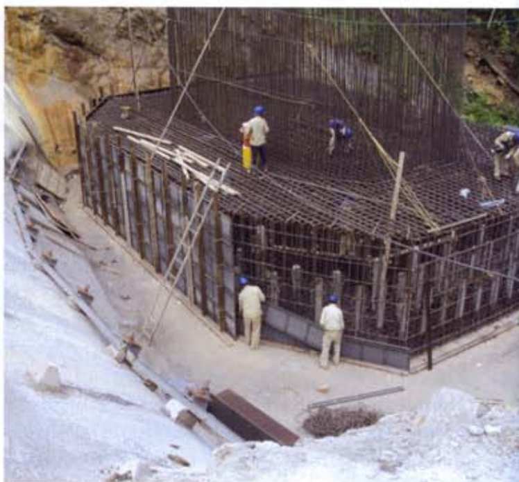
Fig. 10 - Inizio della cassetteria del plinto e armatura dell'elevazione della pila 1 (si intravedono tra le armature i micropali di rinforzo)
