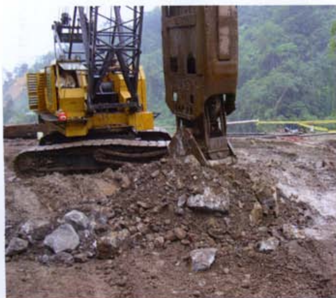
Fig. 8 - Esecuzione dei diaframmi e armatura del plinto della spalla sud
