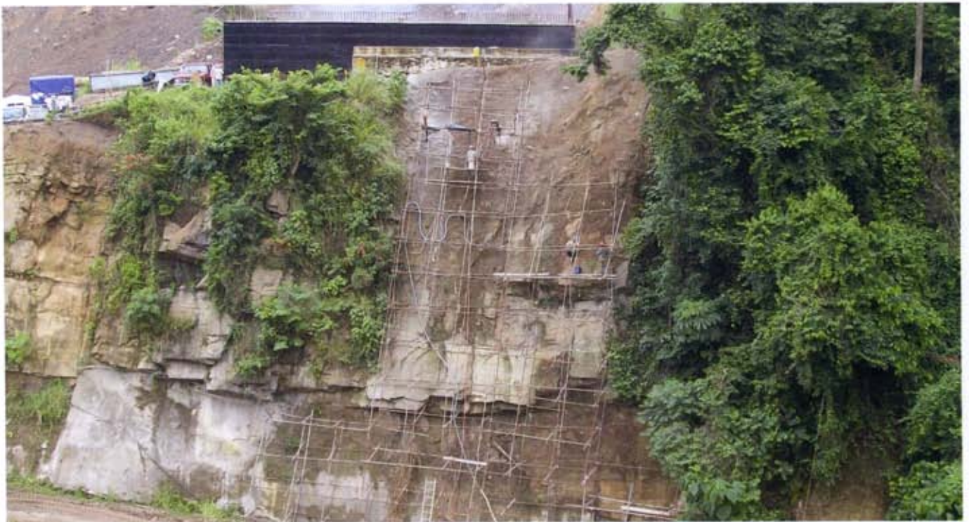
Fig. 26 - Gli interventi di chiodatura del bancone di arenaria della spalla nord
