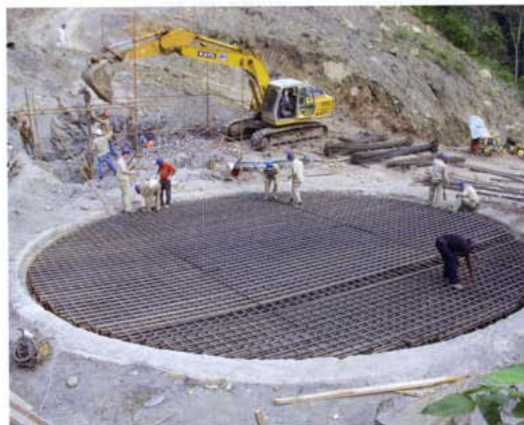
Fig. 14 - Armatura di collegamento tra il pozzo e il plinto della Pila 2
