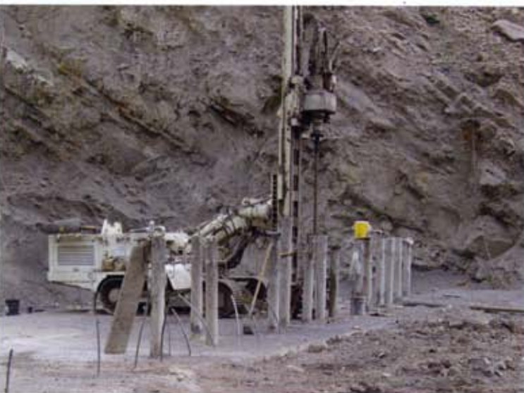
Fig. 9 - Esecuzione dei micropali e armatura del plinto della pila 1
